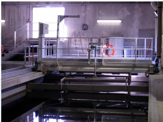
Des lames de raclage réglables, des guides latéraux et des renforts en profilés aluminium assurent une collecte homogène, réduisant les pertes sableuses.
