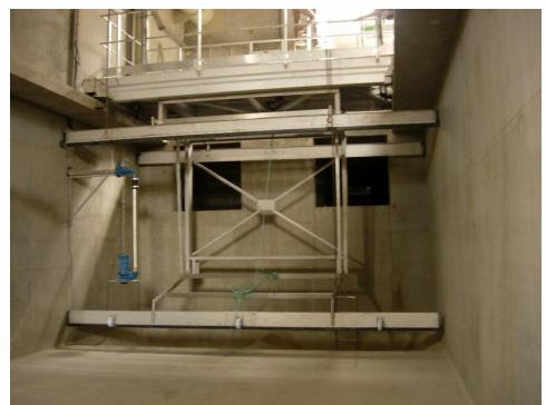
Le dessableur longitudinal est un équipement clé du prétraitement en station d'épuration, destiné à éliminer les matières minérales lourdes (sables, graviers, particules denses) afin de protéger les ouvrages aval, limiter l'abrasion des pompes et réduire l'accumulation de dépôts dans les ouvrages biologiques. Installé en canal ouvert, il s'appuie sur un écoulement régulé permettant la décantation gravitaire des sables tout en maintenant en suspension les matières organiques.
